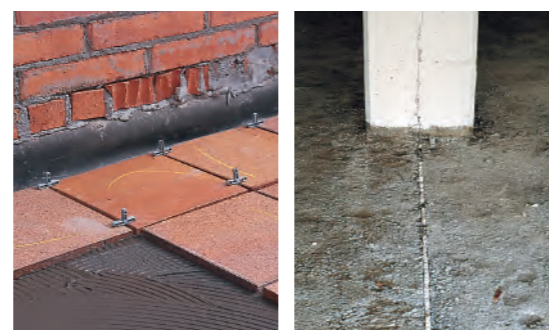
JUNTAS DILATACIÓN EXPANSION JOINTS
